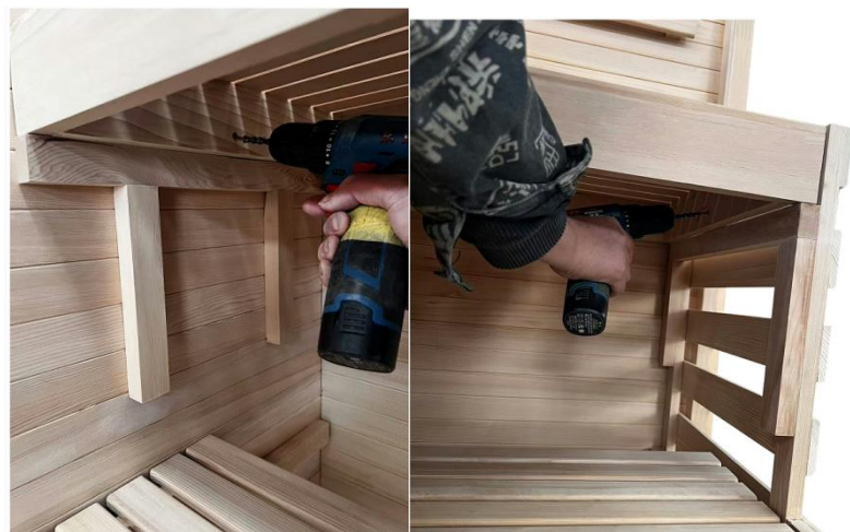
(8) Използвайте винтове, за да закрепите лявата и дясната страна под скамейката, вижте снимките по-горе, използвайте винтове 4x50mm
