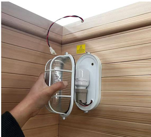
(11) Installieren Sie die wasserdichte Abdeckung des Saunalichts (4x12mm Schrauben)
