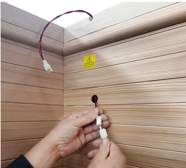
(9) Saunalichtkabel wie oben anschließen.
