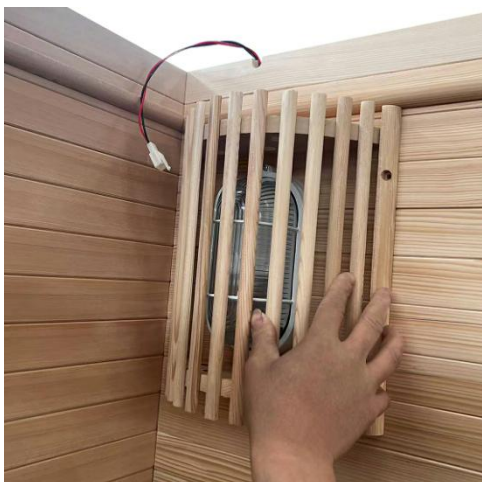
(12) Zostavte drevený kryt na saunové svetlo (skrutky 3x25mm 8 kusov)
