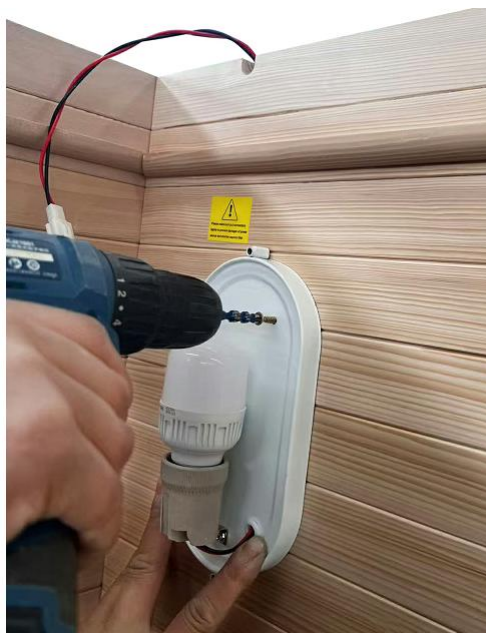
(10) Pomocou skrutiek pripevnite kryt svetla do sauny (skrutky 3,5 x 25 mm, 2 kusy)
