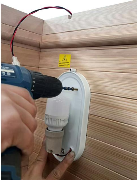
(10) Schrauben zur Befestigung der Saunalichtabdeckung verwenden (3,5x25mm Schrauben 2 Stück)
