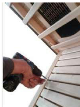
(9) Postavite klupu i upotrijebite vijke 4x50 mm da pričvrstite klupu
